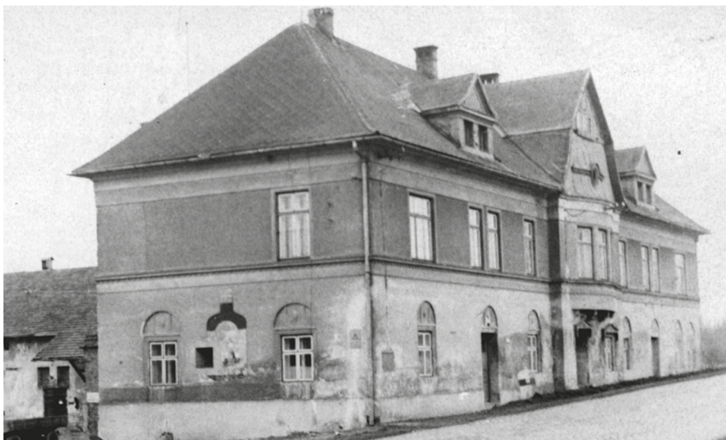
Budova bývalé Glesingerovy likérky ve Vojkovicích, dnešní Koničkův dvůr.
