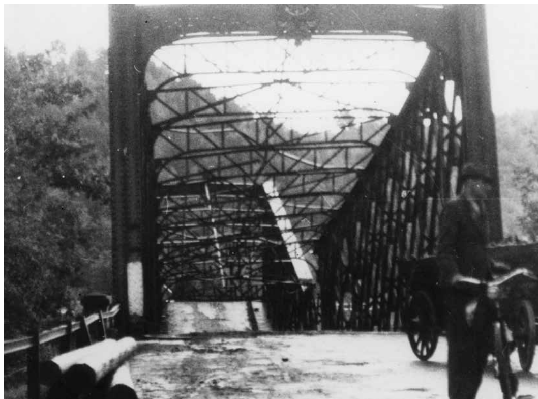
Most kardinála Koppa přes řeku Morávku.
