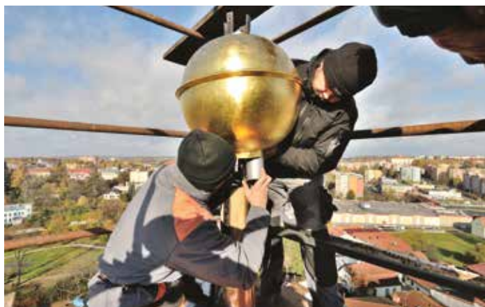
Ukládání časové kapsle do věže frýdeckého zámku, 2016.
