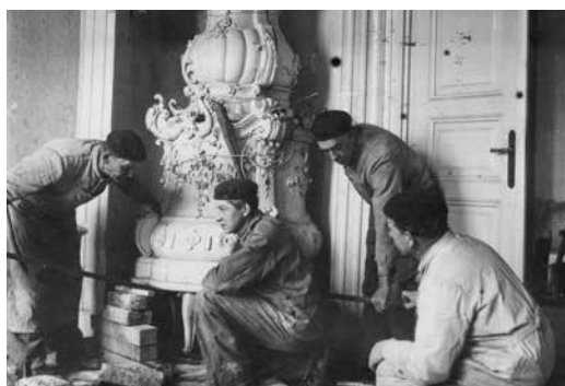
Od roku 1960 se muzeum postupně stěhovalo do uvolněných prostor zámku, s tím byly spojeny rozsáhlé stavební úpravy.
