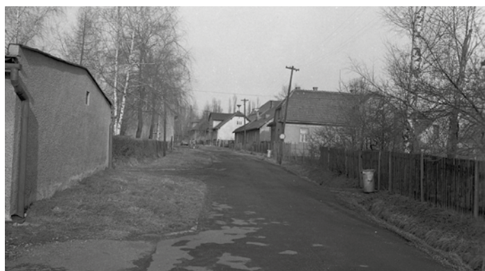
Demolice stávající zástavby v Janského ulici ve Frýdku, 2. polovina 70. let 20. století. Foto | Muzeum Beskyd Frýdek-Místek
