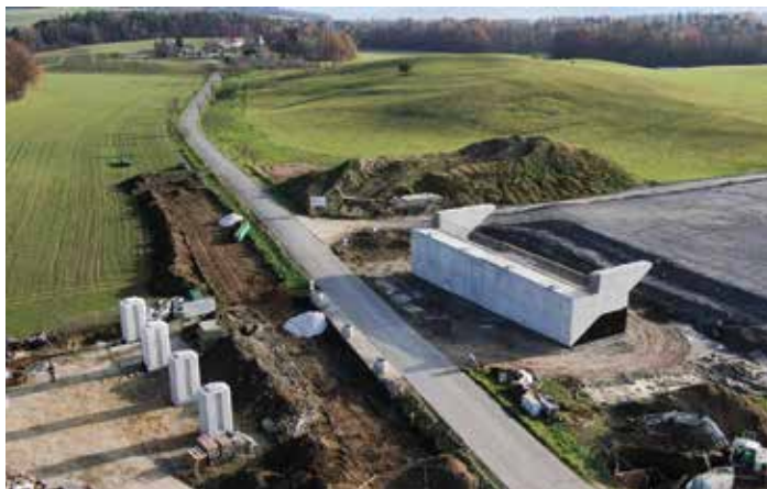
Stavba přemostění na trase obchvatu Frýdku-Místku nedaleko Skalice.
