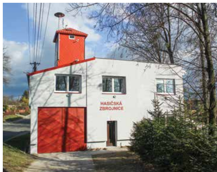
Zrekonstruovaná hasičská zbrojnice ve Skalici
